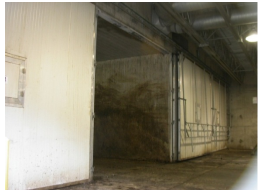
Figure 19: Tunnels fermés statiques aérés. L'aération passe par la base avant de circuler à l'intérieur du tunnel et d'être évacué par un biofiltre.
