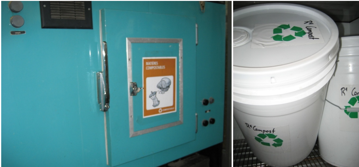
Figure 63: (a) Pièce réfrigérée pour entreposer des matières organiques pour plus d'une journée. (b) Contenants avec couvercle pour limiter la propagation des mouches dans les matières organiques collectées.
