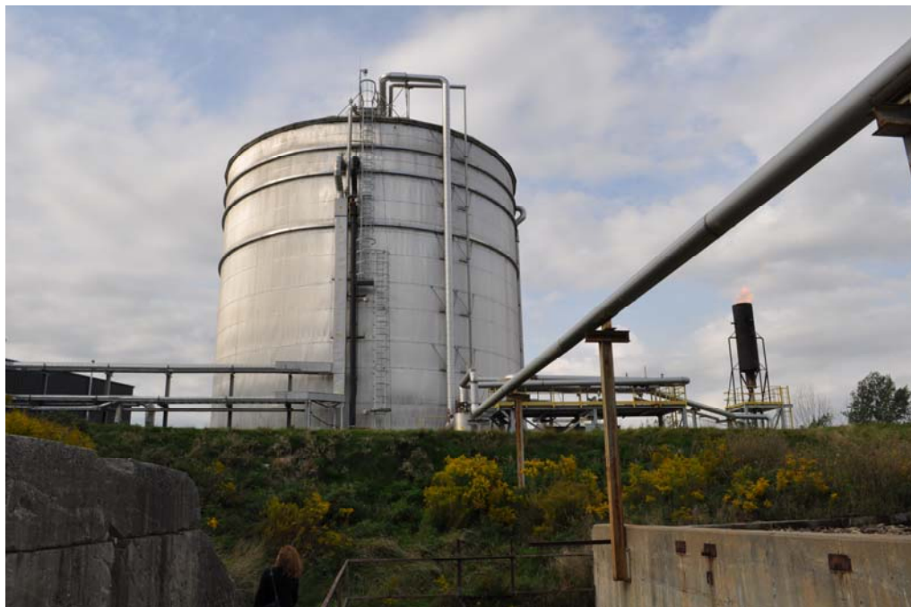
Figure 23: (a) Plan d'installation d'un digesteur anaérobie produisant du méthane transformé en électricité couplé à un composteur pour achever la maturation de la fraction solide du substrat produit destiné à une ICI 111 . (b) Installation municipale de digestion anaérobie traitant les résidus de Toronto (photo Louise Hénault-Ethier).
