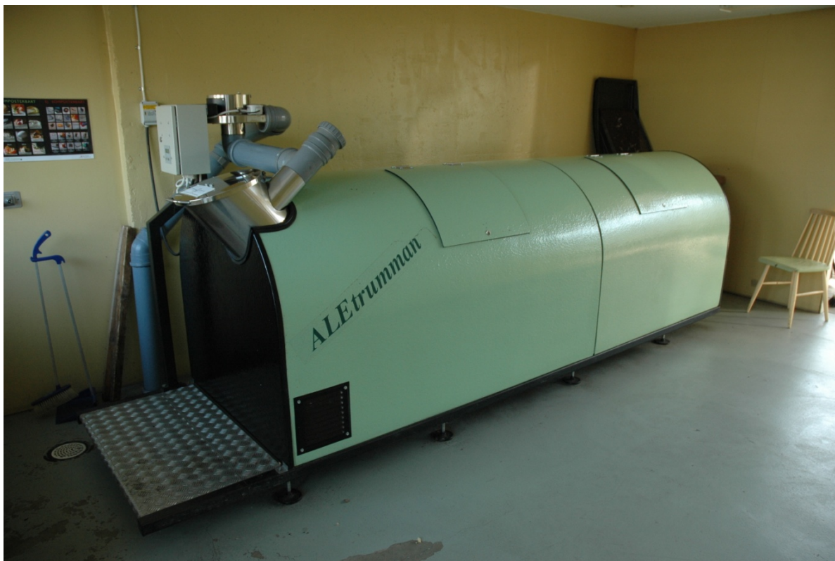
Figure 85: Expulsion de l'air vicié d'un composteur modulaire directement dans un système d'égouts (en Suède) (photo Louise Hénault-Ethier).
