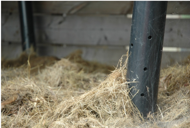
Figure 93: Ventilation passive dans une boîte de compostage assurée par un tuyau perforé (photo Louise Hénault-Ethier).
