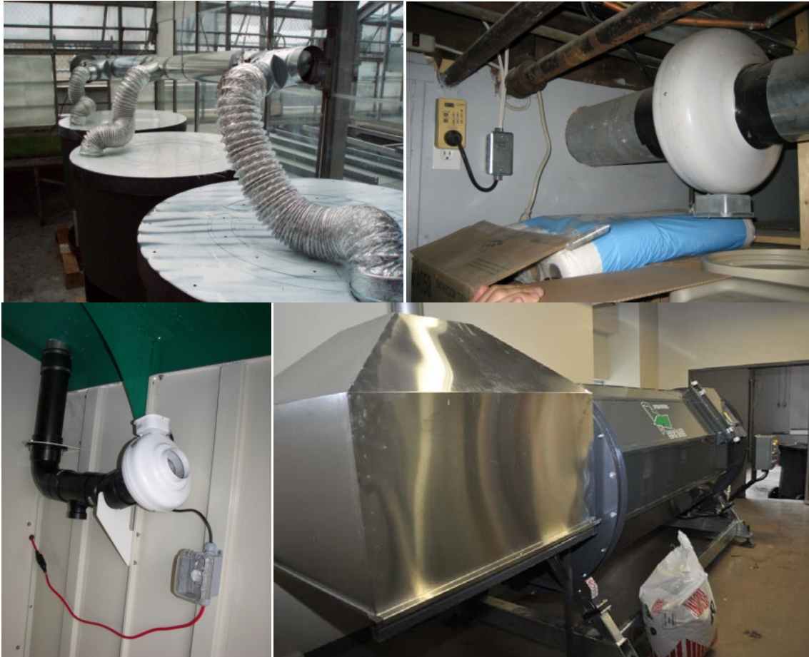
Figure 33: (a) Système d'évacuation d'air directement connecté à des unités de vermicompostage à l'Université Concordia. Notez que ce système améliore la qualité de l'air intérieure, mais contribue aussi à conserver une température fraîche à l'intérieur des vermicomposteurs qui sont situés dans une serre. (photo Louise Hénault-Ethier) (b) Système d'évacuation de l'air dans une installation de vermicompostage située dans un sous-sol au Santropol Roulant (photo Louise Hénault-Ethier). (c) Système de Ventilation pour évacuer l'air vicié sous l'abri d'un composteur (photo Paul Larouche). (d) Système de captation de l'air à la sortie d'un composteur intérieur pour l'évacuer à l'extérieur de l'édifice à l'ÉTS à Montréal (photo Alexis Fortin).
