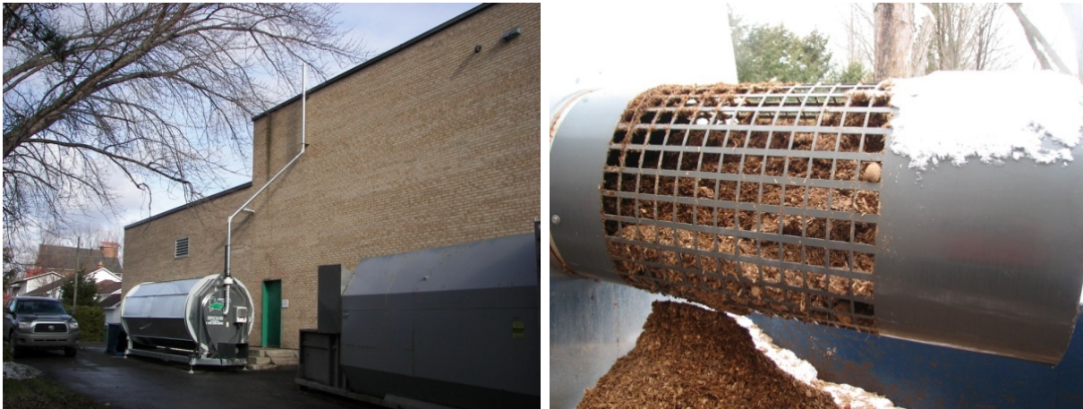
Figure 131: Équipements complémentaires ajoutés au bioréacteur (a) une cheminée qui permet de diffuser l'air sortant du composteur et (b) tamis permettant de séparer le compost des débris récalcitrants ayant un trop gros diamètre (photos Paul Larouche).
