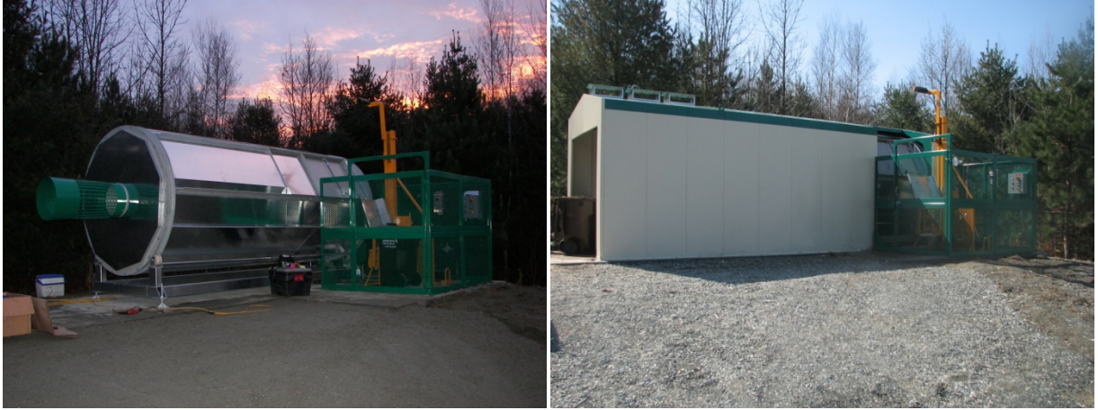
Figure 108: Système de compostage in situ de l'Université Sherbrooke (a) pendant l'installation et (b) avec son abri pour protéger le système et les travailleurs des intempéries (photos Alexis Fortin)
